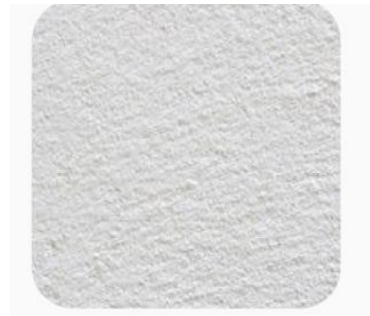
Muros: aplanado de yeso a regla y plomo con sellador 5x1, pintura comex Vinimex total y pasta marca PINTEX textura arenada.
